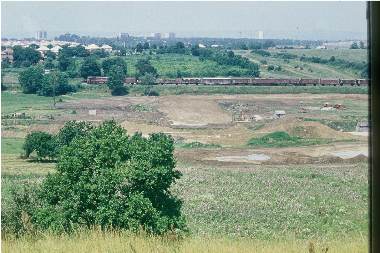
A tó gátrészének építőmunkálatai, a háttérben Nagykanizsa.
