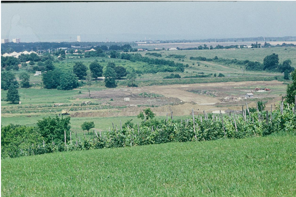
Pillanatkép a gát építéséről
