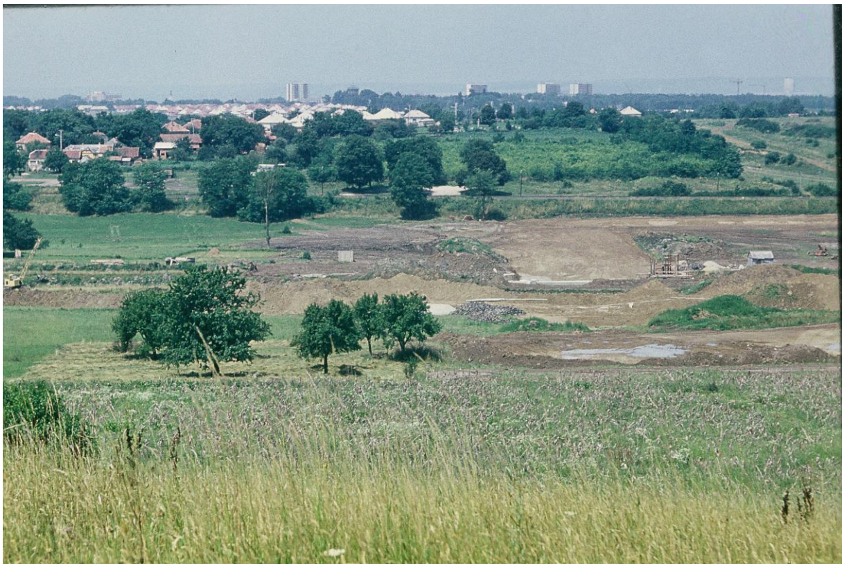
Táj a város felé, előtérben a zsilipház, árapasztó és a gátépítő munkagépek
